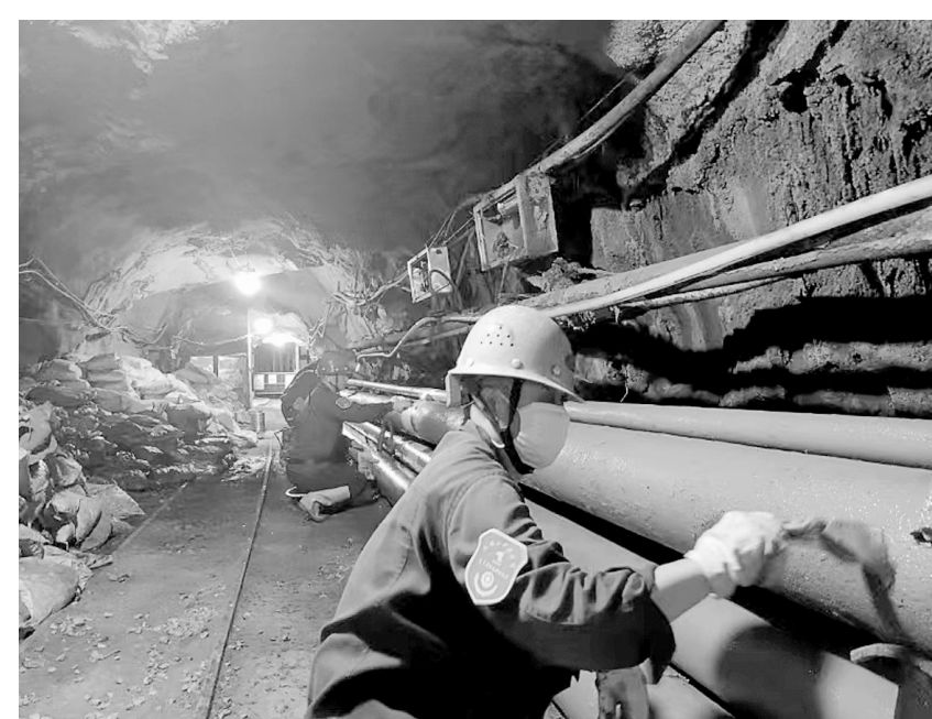
图为天马山矿业公司持续开展井下防洪工作。
