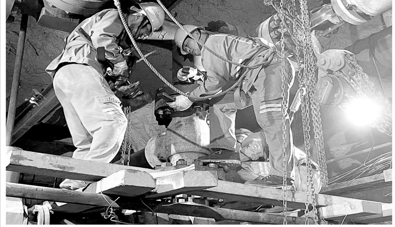
8月1日,冬瓜山铜矿提升二区维修工正在井下负875米泵房更换泵逆止阀。由于矿山井下特殊的地质环境,加上前期梅雨季节,大量的雨水流入地下后对地下岩层造成渗水现象,井下排水工作尤为复杂和艰巨。该矿加大对排水设备的维护保养力度,增加巡查频次,发现问题及时处理,确保排水设备正常运转,保障井下安全生产。
