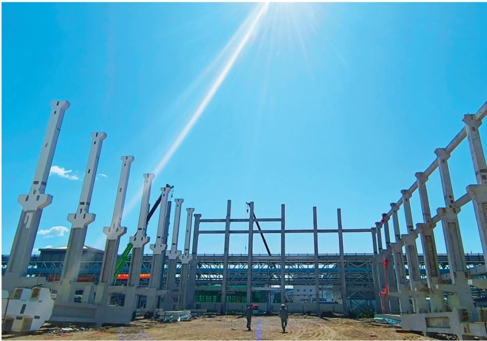
铜冠建安公司第一建筑工程事业部承建的内蒙古赤峰金通二期扩建项目46根预制柱日前全部顺利吊装完成。在该项目施工上,第一事业部赤峰金通项目部通过多次论证施工方案,科学组织,吊装过程中克服了局部吊装空间狭小,特别是二期预制柱要在—期的基础上进行吊装,并与—期预制柱间隔小等诸多困难,经过项目部全体人员共同努力,用时21天顺利完成吊装任务。
