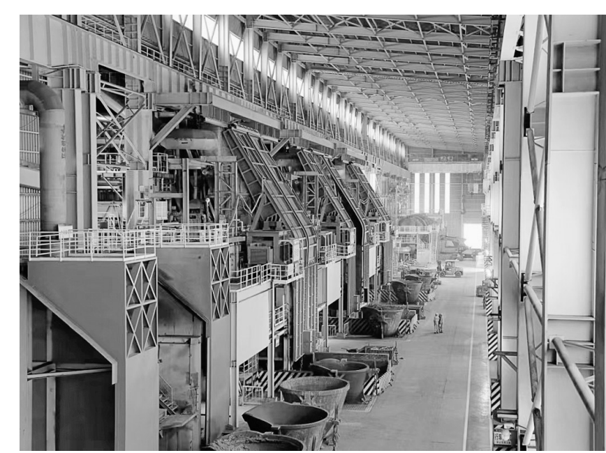
图为奥炉工程熔炼主厂房。
