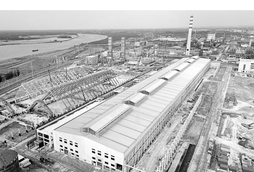
图为铜冠建安公司在建的铜基新材料项目电解主厂房及精矿库全貌。
