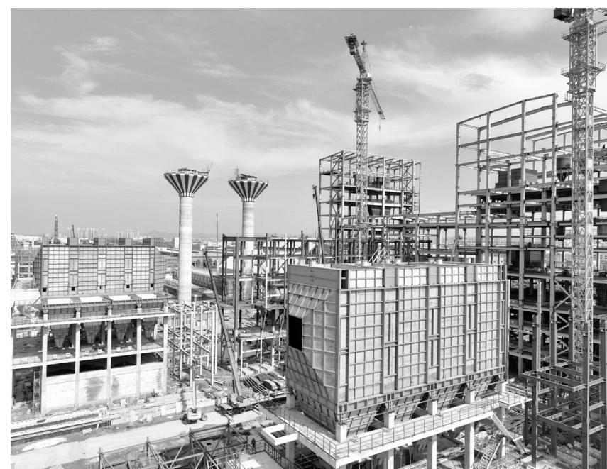
图为铜基新材料项目施工现场。
