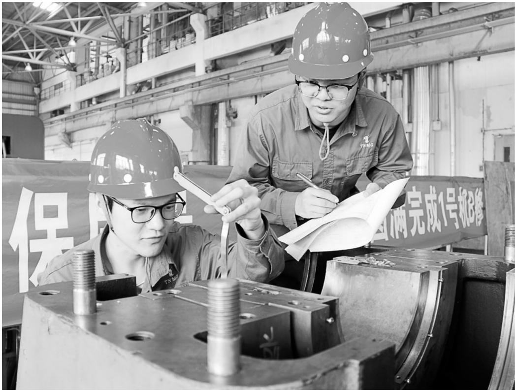
近日，动力厂热电1号机组各项重点检修项目均按计划推进中，完成了1号汽机叶片、汽轮机轴瓦、气封间隙调整等系列检修项目。该厂热电车间技术人员测量汽轮机轴瓦间隙，并做好记录，把握关键设备每一处细节的检查和处理，保障大修工作质量。
