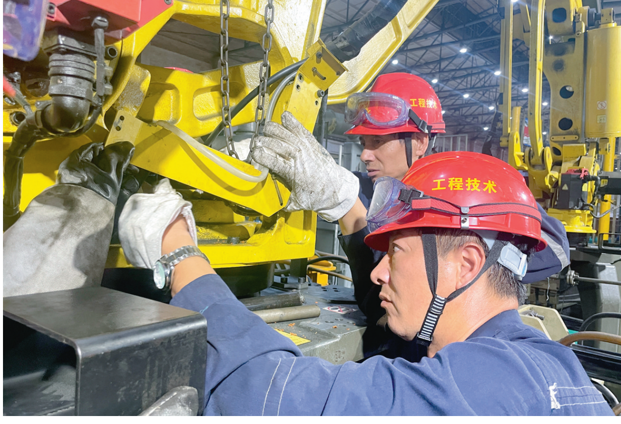
工程技术分公司持续加强核心技术攻关,积极拓展专业化、精细化维修。图为近日该公司金隆项目部维修技术人员对金隆铜业公司PC1号剥片机组2号机器人进行抢修工作场景。 通讯员 陈 陈 摄
