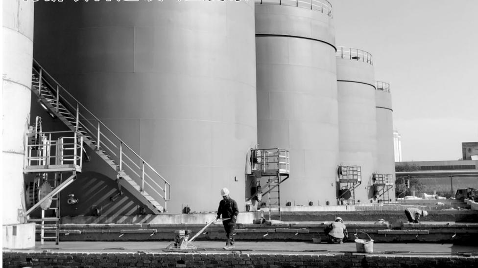
铜冠建安公司第二建筑工程事业部抢抓施工黄金期，在保证安全的前提下全力冲刺，不断刷新项目建设“进度条”，确保如期完成各项目建设目标。图为5月23日，金泰化工新能源项目建设者们正在施工甲醇钠储罐区域地坪。
