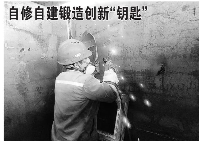
张家港铜业公司始终秉承自修自建的优良传统，不断提升自主创新能力。今年，该公司动力车间自主设计、制作了精炼车间的布袋收尘器。目前布袋收尘器已进入设备安装阶段。图为该公司动力车间工人日前对布袋收尘器箱体进行焊接。
