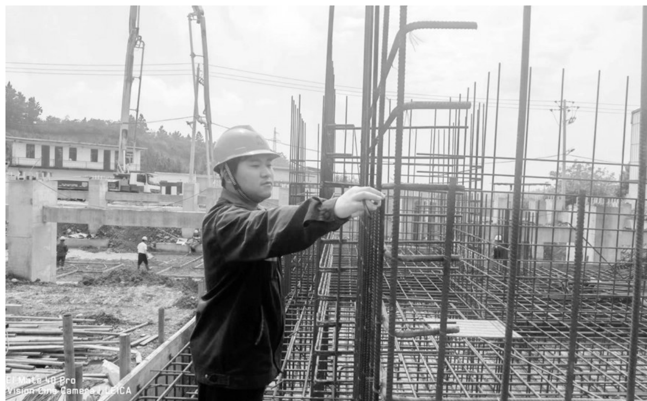
图为张思涵在工地现场抽样检测的情景。
