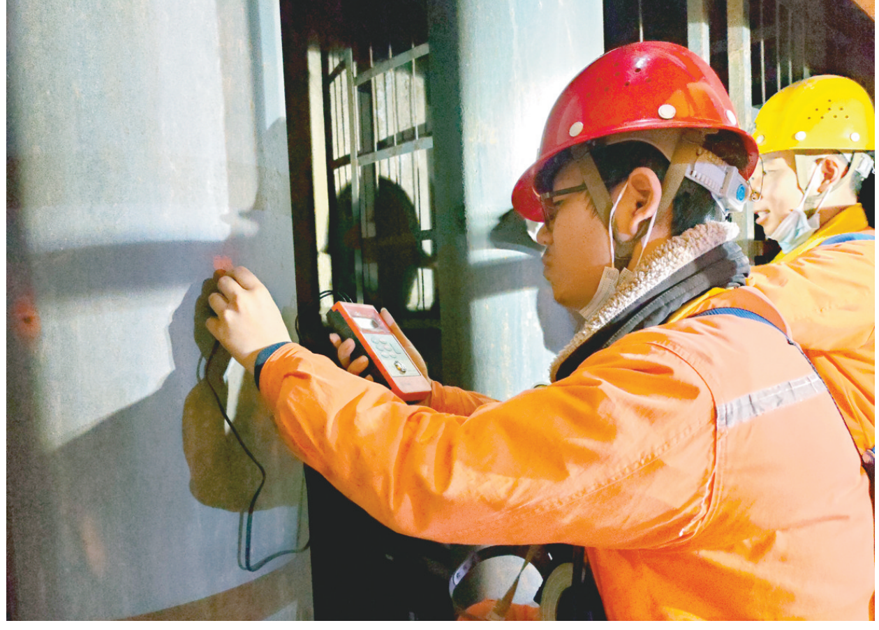
日前,铜冠(庐江)矿业公司动力运转中心职工使用超声波测厚仪检测排水管道壁厚。汛期将至,该公司严格按照防汛防汛总体部署,压实责任,落实措施,强化对各重点岗位和设备设施检查力度,确保安全度汛。通讯员 吴树华 洪亿昆 摄
