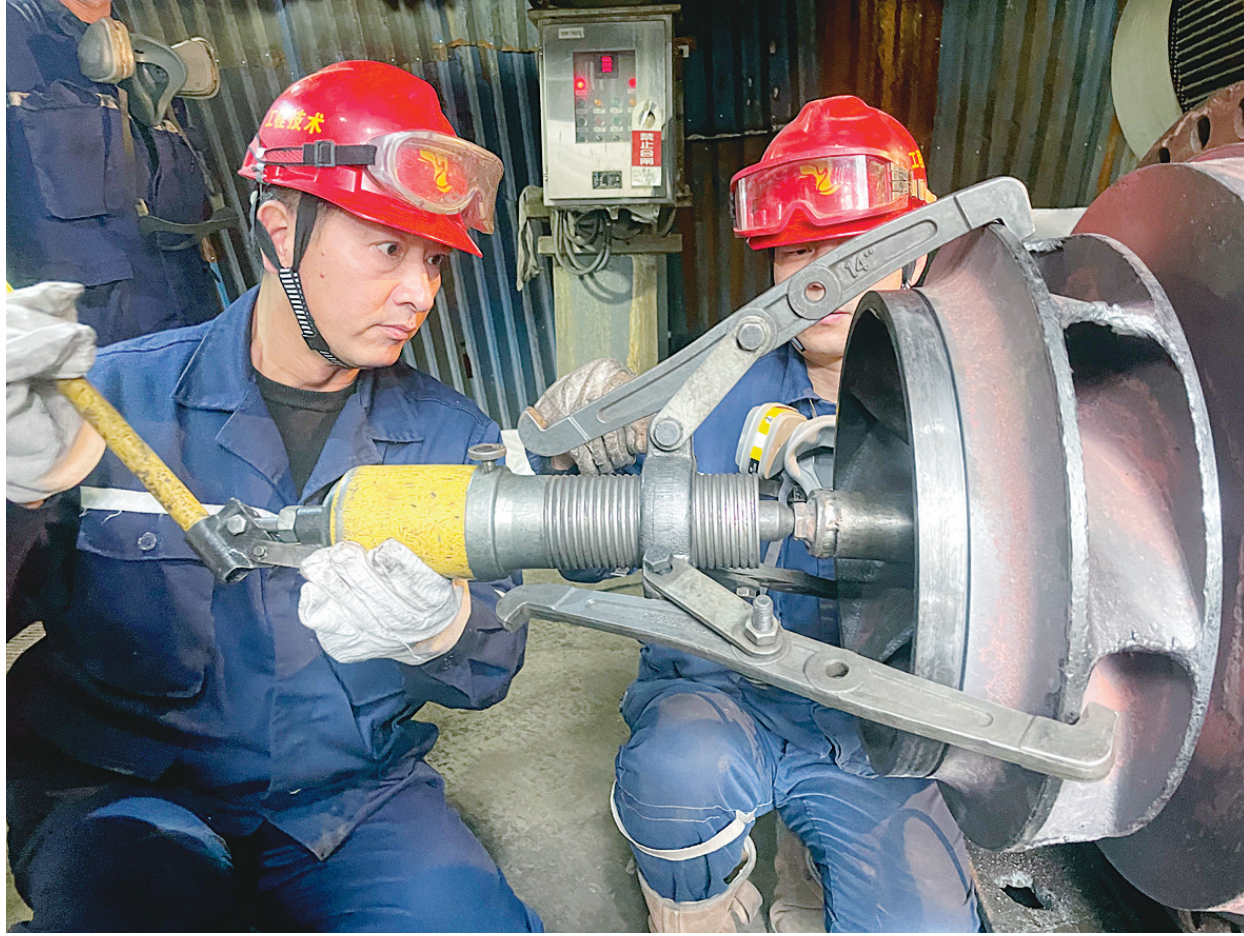
今年以来,工程技术分公司金隆项目部加强专业化、标准化检修,积极采用先进的专业工具,合理使用各种测量监测仪器,不断提高检修质量和检修效率。图为近日该公司现场检修人员根据检修的实际情况和各类数据,进行综合分析、找出问题,提出改进措施,对金隆铜业公司闪速炉循环泵进行专业化维修。
