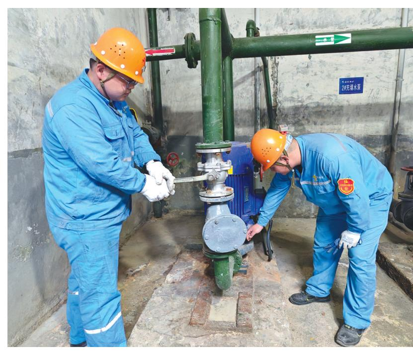
近日,安庆铜矿工程工区组织青年突击队对生产区域设备设施进行隐患排查,先后对工区内消防设备、电气设备、防洪设施等逐一进行点检并完成了空压机加油、灭火器更换、油漆漆分类等工作,及时消除了一些潜在的安全隐患。图为青年突击队员正在对该工区充填站一楼水泵进行检查并对螺栓进行加固。
