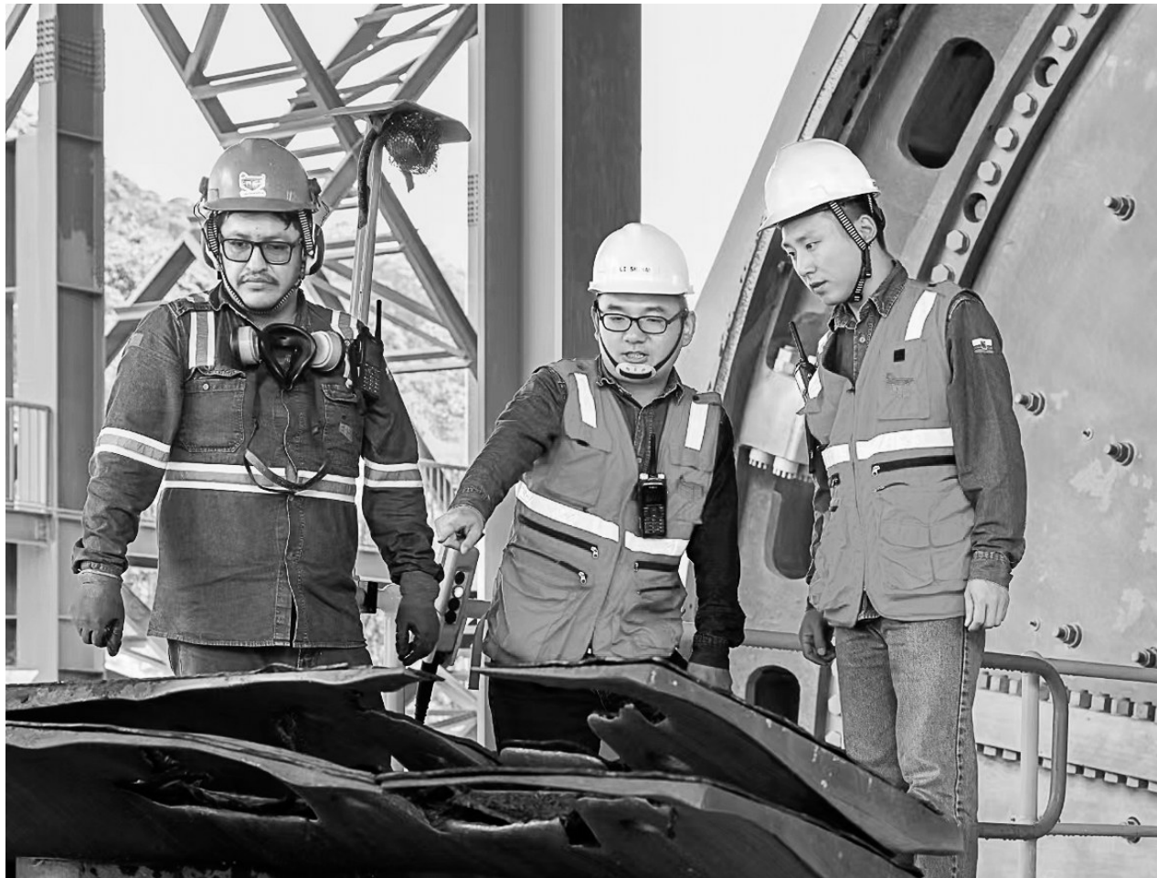
图为米拉多铜矿选矿厂厂长李世男(中)和副厂长宋崇耀(右)与厄方员工在检修现场讨论更换衬板事宜。
