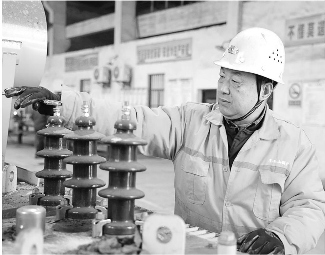
自年初起,冬瓜山铜矿动力车间有序更换大塘泵房老旧变压器,将之前排查出的高耗能淘汰的320千伏安培油浸变压器,升级为性能优越的SRN-M-1600/6型变压器。此次升级,不仅降低了电力设施能耗,还为大塘泵房提供了高低压两路供电和1台备用变压器,确保了全矿生产水内循环运行供电的安全性、可靠性。图为1月9日,该矿动力车间职工正在对新变压器进行检查、调试,开展反送电冲击试验。
