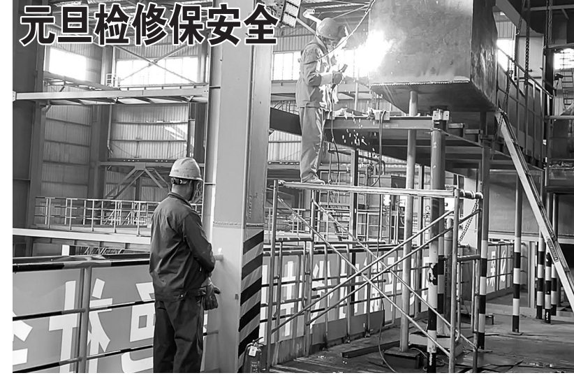
元旦检修保安全。元月1日,铜冠(庐江)矿业公司选矿车间职工正在对球磨机进料管进行维修加固,确保稳序进料。新年伊始,该车间持续以做好“设备文章”为切入点,提前消除设备隐患,保证设备运行工效,为实现元月份精彩开局奠定坚实基础。胡婷婷
