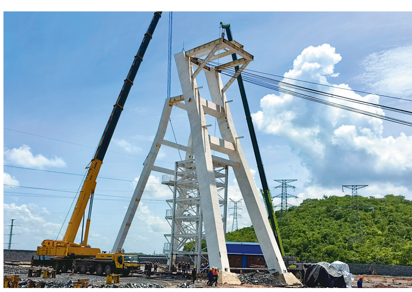
刚果(金)当地时间2023年12月28日,铜冠矿业公司承建的科米卡矿业公司副井永久井架,历时一天半时间完成吊装。该井架的落成刷新了铜冠矿业公司类似井架的吊装合拢时间,在刚果(金)市场树立了良好的企业形象。周志 曾红林 摄
