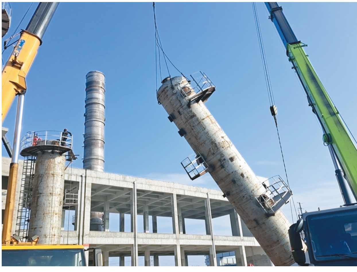
为确保承接的金泰化工公司改造项目施工进度,1月4日,工程技术分公司循环园项目部金泰综合班和冶金机械班通力合作,分工实施二乙醇项目207塔节吊装,在做好充分的施工准备后,根据天气条件合理安排吊装施工,预计5天内完成安装施工。图为该公司循环园项目部检修人员进行207塔节吊装场景。
