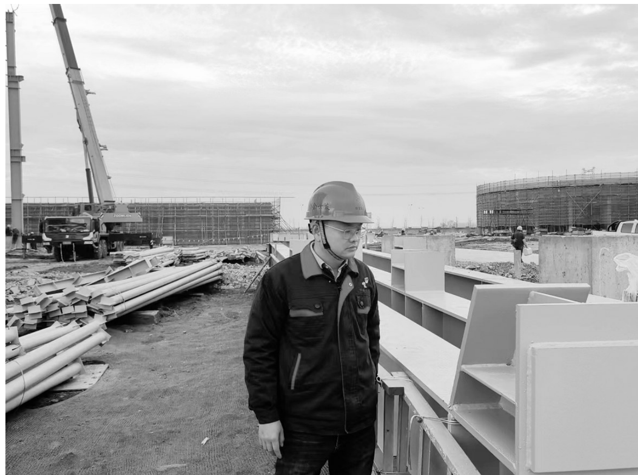
图为余世友正在查看钢构件油漆观感度。
