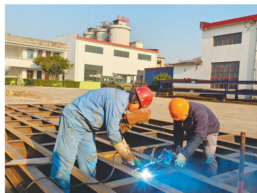
近年来, 安庆铜矿积极在基层生产单位开展技术创新活动, 解决生产技术中的一些“卡脖子”难题, 并使矿山形成了良好的技术创新氛围。图为该矿机修技术人员目前正在自行制作环保车辆清洗平台。 杨勤华 摄
