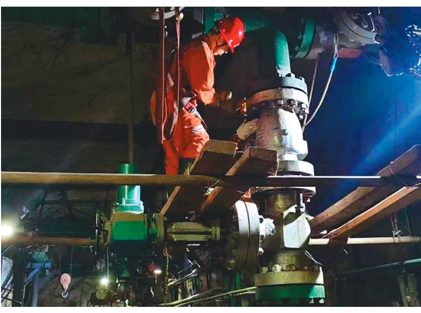
近日,冬瓜山铜矿提升二区对负875米泵房3号泵房逆止阀进行更换。该工区充分做好准备工作,提前做好更换方案并搭建稳固可靠的脚手架。水泵维修人员按照方案相互协作,密切配合,经过5个小时努力,3号泵逆止阀更换圆满完成,并对该泵加油润滑、清理上水管等维护保养,确保水泵安全高效运行,保障坑下水及时排出。 王松平 摄
