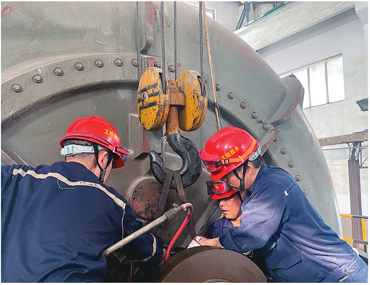
为进一步加强检修标准化管理,确保设备检修质量,工程技术分公司金隆项目部积极推行在检修过程中采取边检修、边检查、边验收的方法,对关键质量控制点会同相关专业技术人员,共同检查和验收,从而避免设备组装后,由于质量问题而返工影响整体施工进度。图为该公司金隆项目部检修人员近日对金隆铜业公司硫酸KKK风机进行严谨的装配。 陈陈 摄
