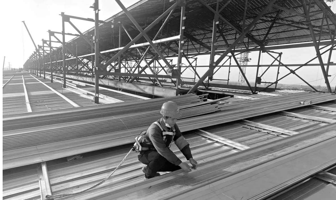
图为陈志伟正在绿色智能铜基新材料电解车间屋面检查屋面瓦搭设稳固性。
