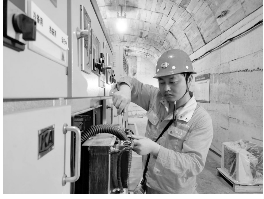
图为胡正鑫在负850中段更换破碎系统断路器。
