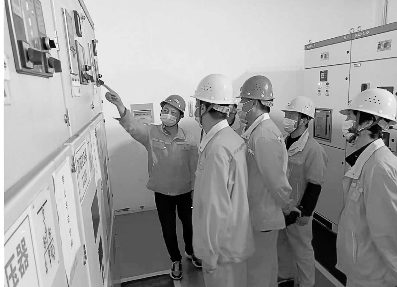
图为胡正鑫(左一)在主井提升机房对班组员工进行安全巡查培训。
