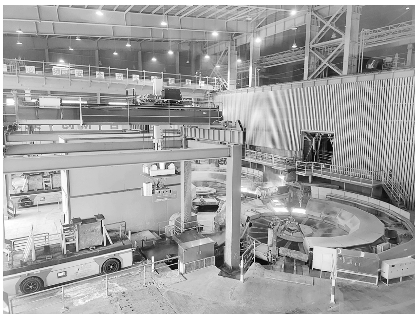
图为金冠铜业分公司双闪精炼车间圆盘浇铸系统及智能运输系统正在生产作业。
