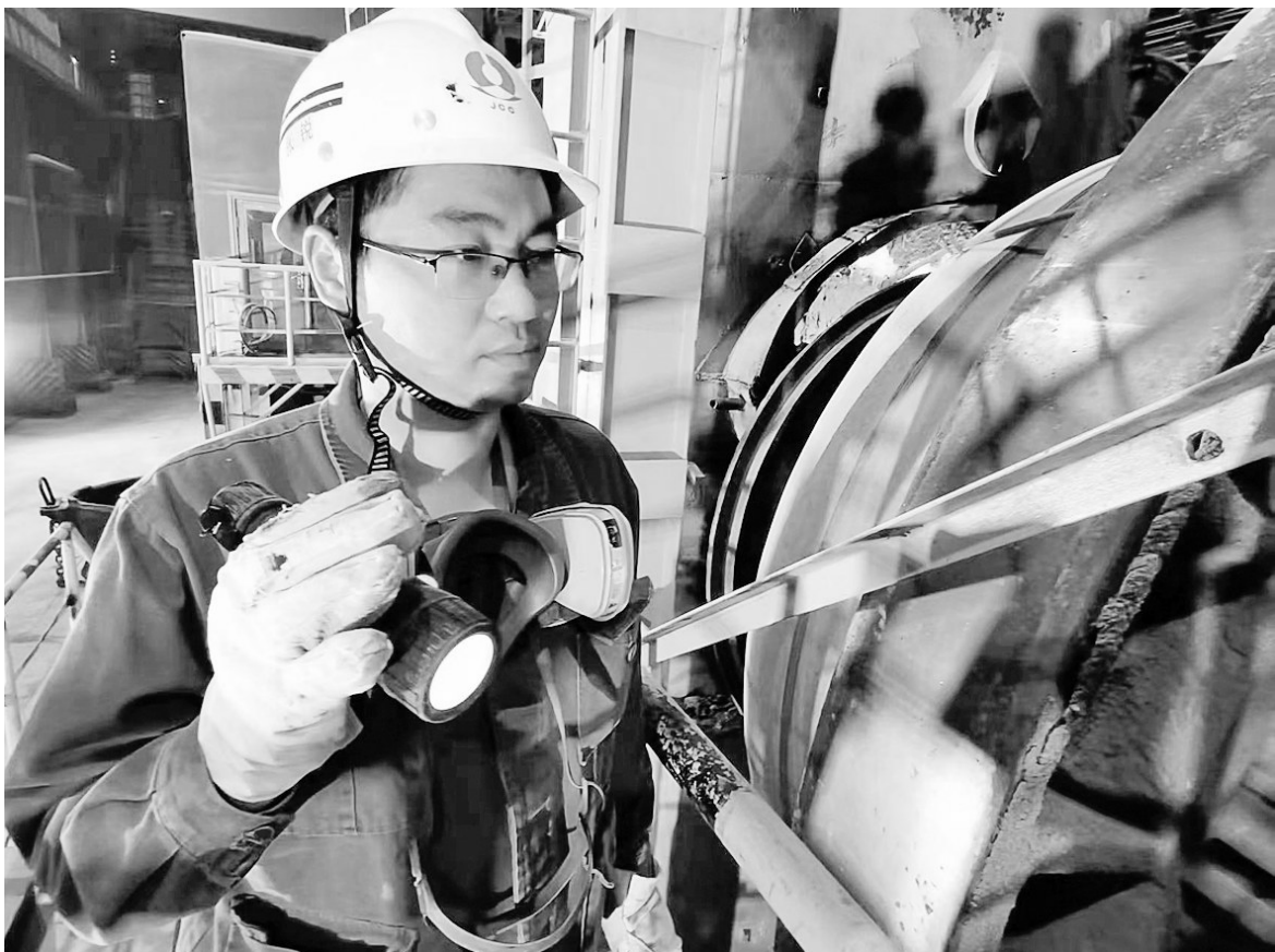
图为张锐在检查炉体运行安全状况。
