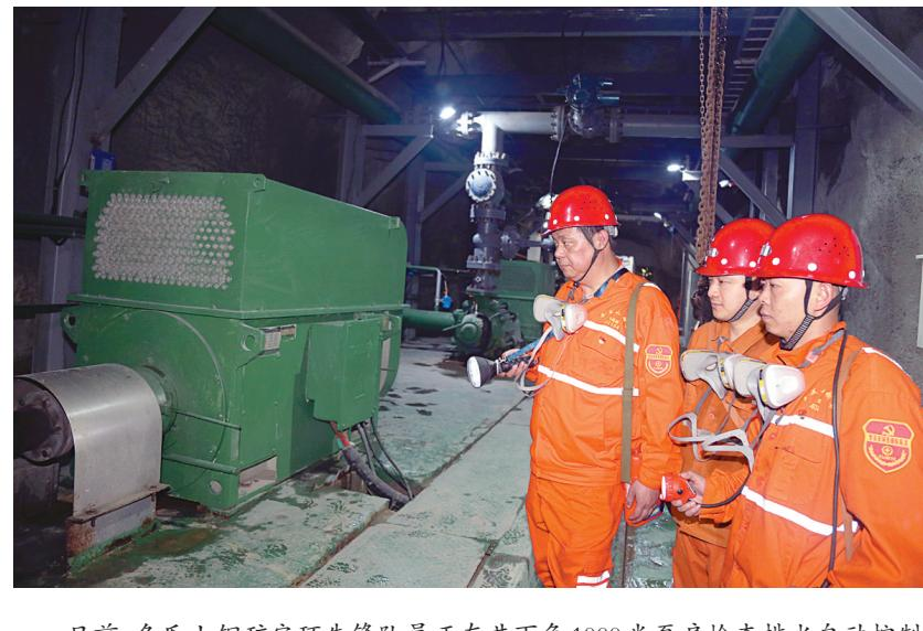
日前,冬瓜山铜矿安环先锋队员正在井下负1000米泵房检查排水自动控制系统运行情况。今年以来,该矿党委党建攻关项目“负1000米中段智能化中段项目”已完成负1000米中段水泵房无人值守系统项目建设,并投入正常使用。项目建成后可以减少负1000米中段井下排水现场操作人员,降低生产成本,提高本质安全水平,大幅度提高工作效率,也为后续生产成本节约创造了条件。
