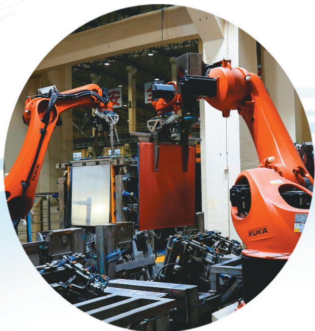
奥炉电解剥片机组
