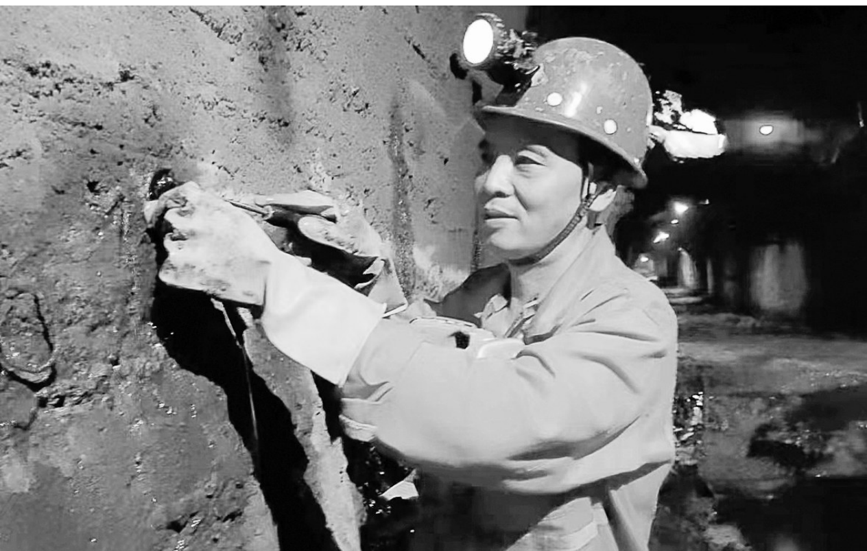
图为高生正在治理采场裂隙渗漏。
