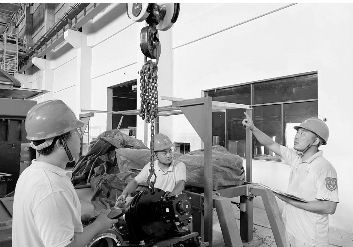
图为伏程斌(右一)对吊装作业进行安全督导。
