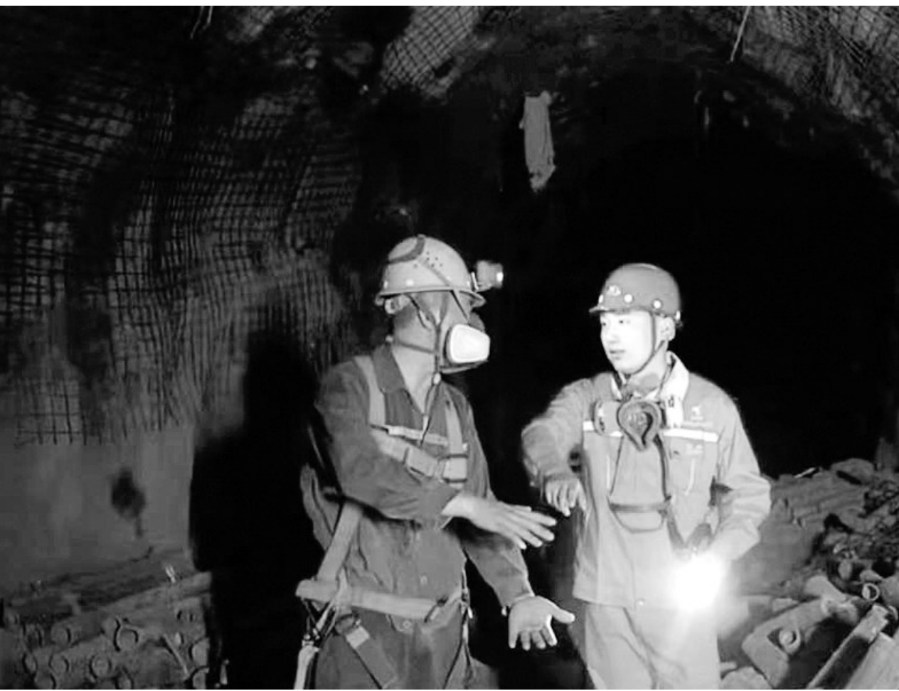
图为赵锐(右一)在负705m中段F-103采场进行爆破装药指导,做好现场交底工作。
