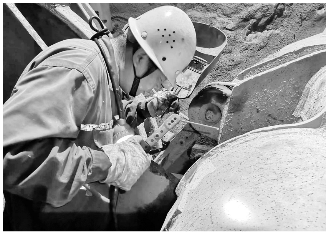
图为程飞在负790米维修区域对设备组件进行焊接。
