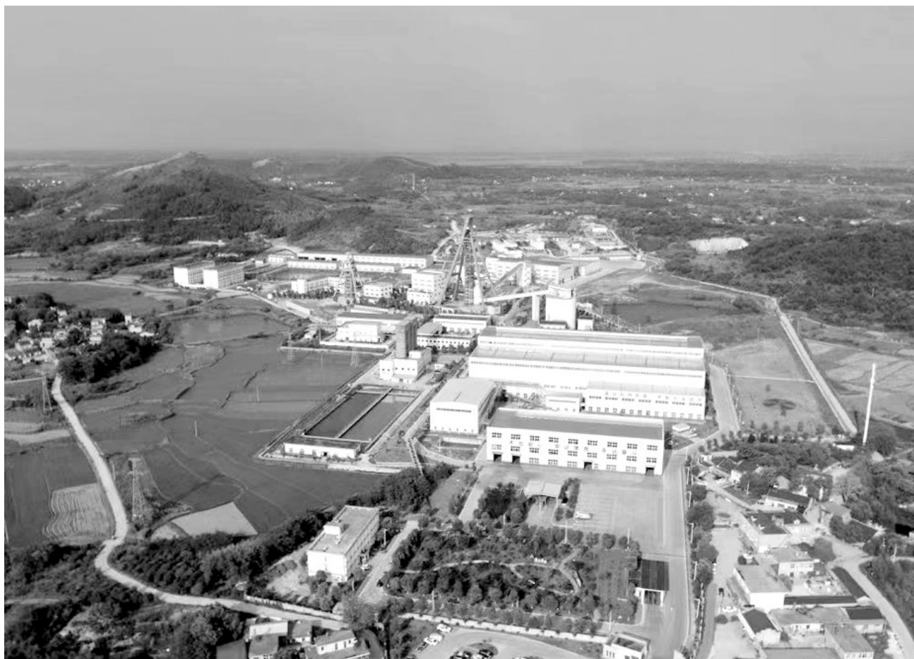
图为安徽铜冠(庐江)矿业公司全景。
