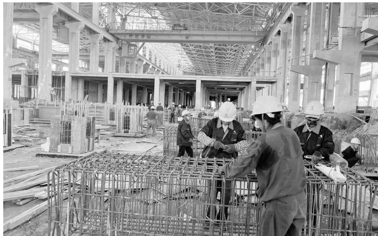
图为建安公司第一事业部承建的江西鑫科项目电解厂房。
