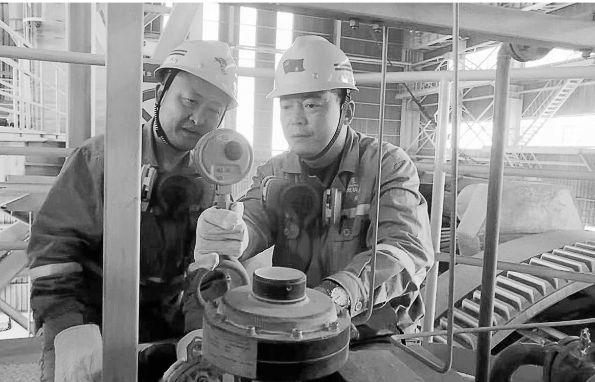
图为吴俊(右)与岗位员工一起点检天然气压力。
