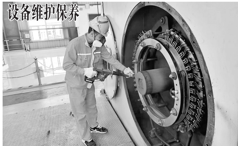
近日,安徽铜冠(庐江)矿业公司动力运转中心开展大型电气设备的运行与管理检查。该中心按照设备维护保养要求,定期组织人员开展大型设备维护和保养工作,努力确保大型电气设备良性运行。高日照 董爱武 摄
