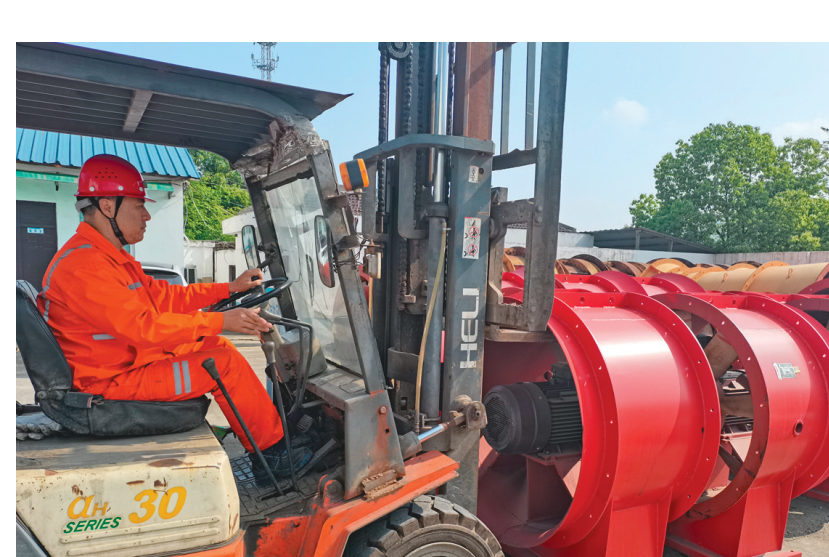
日前，冬瓜山铜矿动力车间职工正在又运风机辅扇。今年以来，该矿在做好井下系统风机维护的同时，适时调整、更换各中段巷道的风机辅扇。截至5月底，就更换11至37千瓦辅扇5台，新安装辅扇、局扇30多台，不断优化井下通风系统，有效改善井下通风作业环境。
