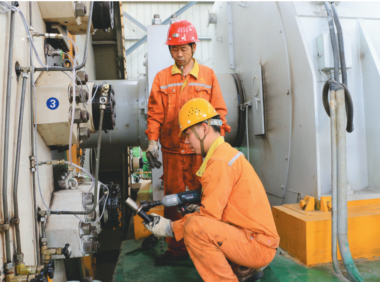
日前,铜冠(庐江)矿业公司完成更换主井间盘油封,确保主井提升安全,为企业冲刺“双过半”奠定基础。图为维修工正在利用工具拆卸间盘盘丝。
