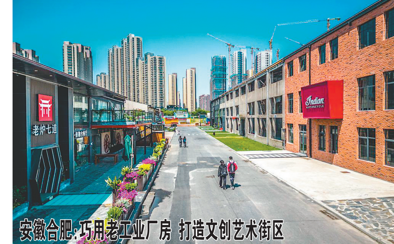
5月9日，市民在由原合肥恒通机械厂老厂房改造的瑶海区180文创艺术街区参观(无人照照片)。安徽省合肥市瑶海区是老工业城区。近年来，该区积极推进老城区城市更新，有效利用辖区老工厂、老厂房、老仓库等资源，创意点亮工业历史，打造了一批集创意办公、文创展示、工业记忆、休闲娱乐及消费等功能为一体的文创艺术街区。 新华网
