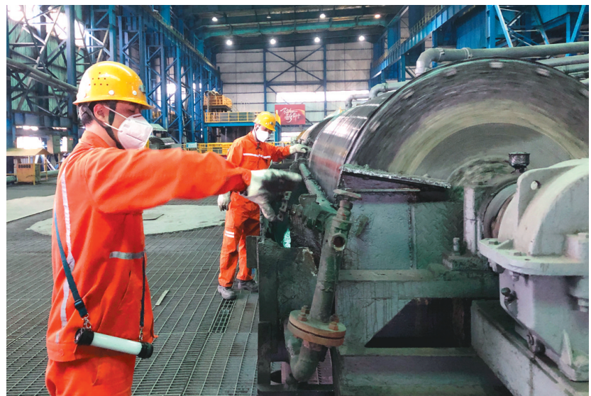
冬瓜山铜矿抓铁设备的使用和维修保养,将日检、周检、月检常态化、规范化和制度化,提高设备运转率。图为近日该矿选矿车间生产工在检查和调试磁选机卸料水管的闸阀。 汤善袁 摄
