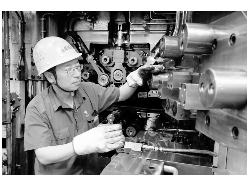
图为姜进正在安装轧辊轴承。
