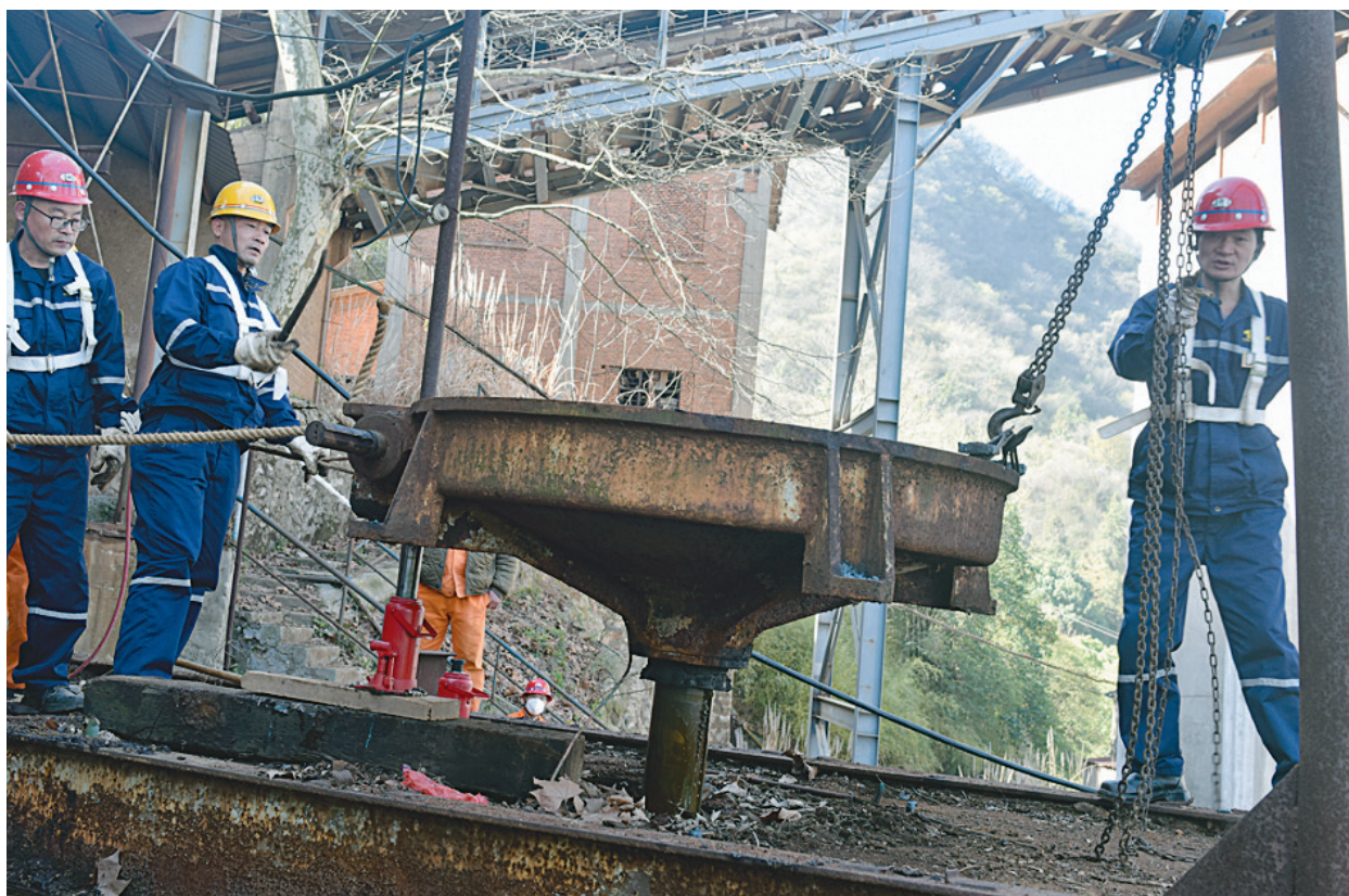
凤凰山矿业公司为扎实做好废旧物资资产处置工作,日前,该矿业公司组织人员拆除原选矿车间石灰乳化搅拌桶废旧设备,保证废旧设备应收尽收。 胡龙海 程震 摄
