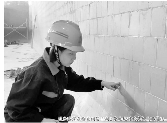
图为路露在检查铜箔三期2号地坑耐酸瓷板铺贴情况。
