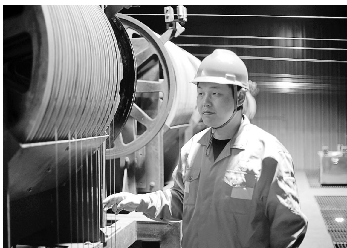
图为王文涛正在检查涂包机天轮运行情况。
