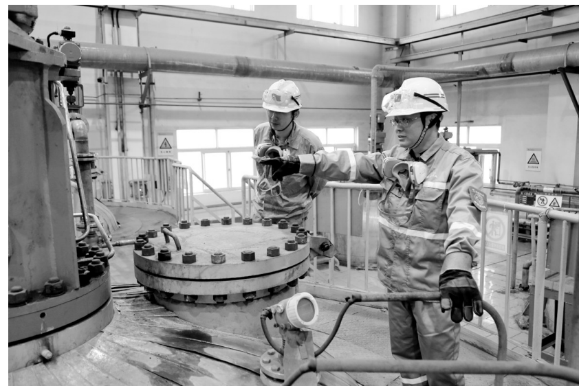
图为涂百乐(右一)对压力釜工艺生产控制进行现场日常检查指导。
