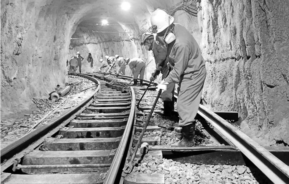
日前,铜冠(庐江)矿业公司组织员工对井下负800米中段13线联络道运输轨道进行更换。据悉,本次更换换损轨道作业历时五天,及时消除了线路安全隐患,全面提升了线路运行质量,为保障运输生产更加平稳运行奠定了基础。
