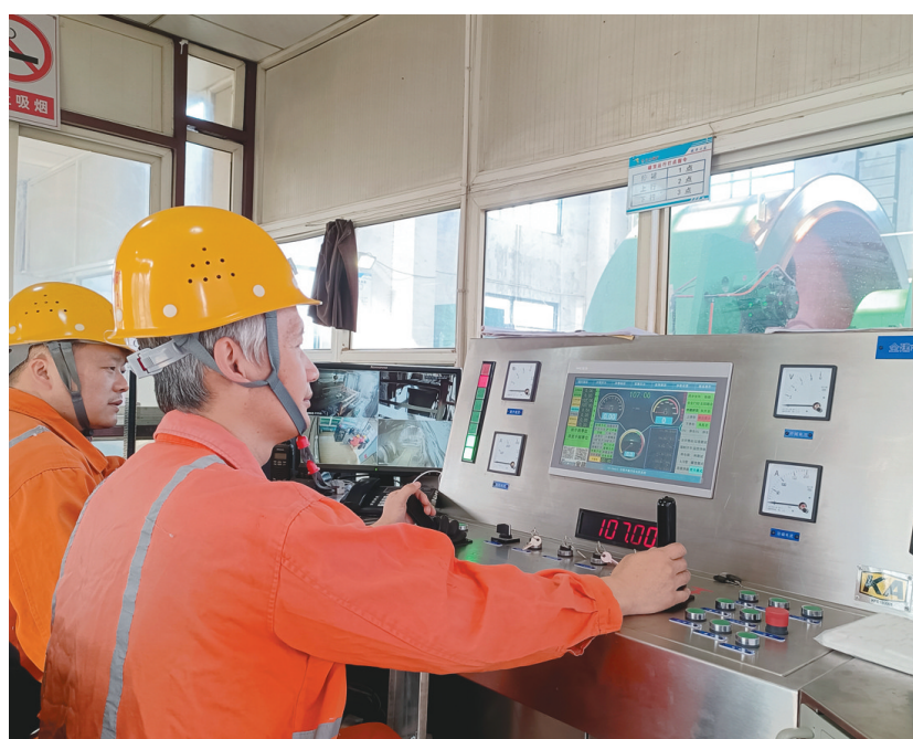
日前，冬瓜山铜矿冬辅助井卷扬机设备升级改造圆满成功。此次改造从2月22日中班开始，该矿提升二区技术员及铜冠建安和烟台全建技术员对卷扬机低压配电箱、励磁控制柜、主控柜、变频器、操作台等大型设备进行拆除并安装上新的设备。安装结束后技术人员与操作人员对卷扬机系统进行全面调试，各项参数符合要求。图为技术人员在调试。王松平 摄
