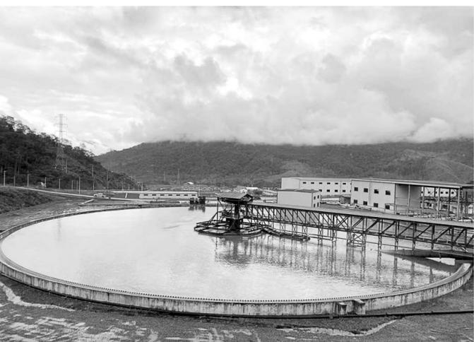
图为铜冠建安公司承建的厄瓜多尔米拉多铜矿2000万吨年采选项目100米浓密池。
