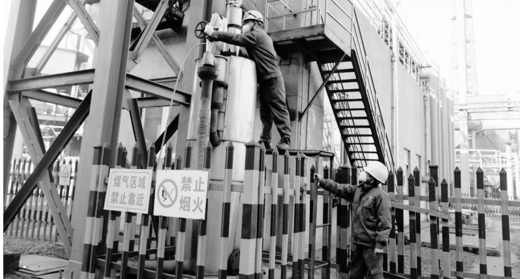
12月24日,铜冠冶化分公司球团车间岗位人员在检查焦炉煤气水封器密封情况。为确保冬季焦炉煤气生产用气安全,该分公司球团车间加强对焦炉煤气加压站、管道阀门、水封器等重点场所和设施设备的日常巡检监护,及时防泄漏、除隐患、保安全。
