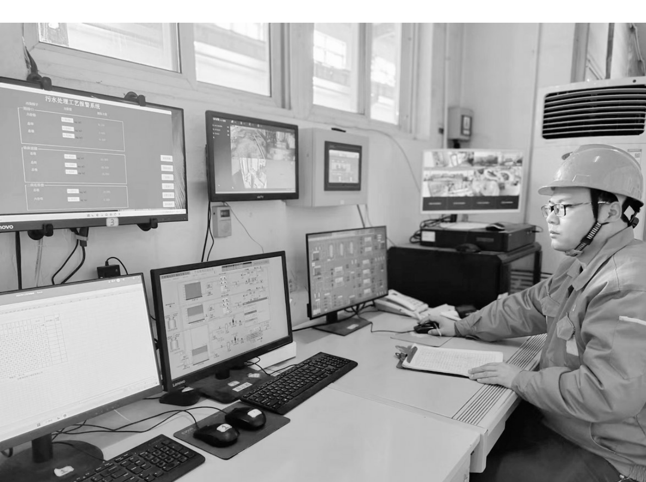
图为周小柱正在监控水处理各系统的运行状态。
