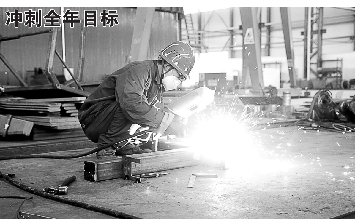
铜冠机械公司加工分厂员工日前正在焊接加工。铜冠机械公司加工分厂根据在手加工业务,结合工期要求,认真开展好年内加工生产,加快制作进度,努力确保四季度圆满收官。
