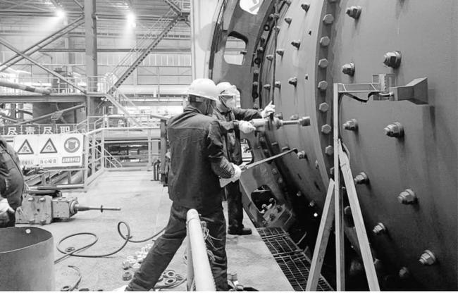
在日前铜冠建安安装公司承接的金冠铜业分公司选矿车间设备调整检修任务中,安装公司员工采取“两班制”方式进行24小时连续作业,26名专业施工人员共同努力仅用48小时完成了溢流型半自磨机80块、重达40吨的衬板及160条重型螺栓更换任务,保障了业主的正常生产。图为抢修现场。
