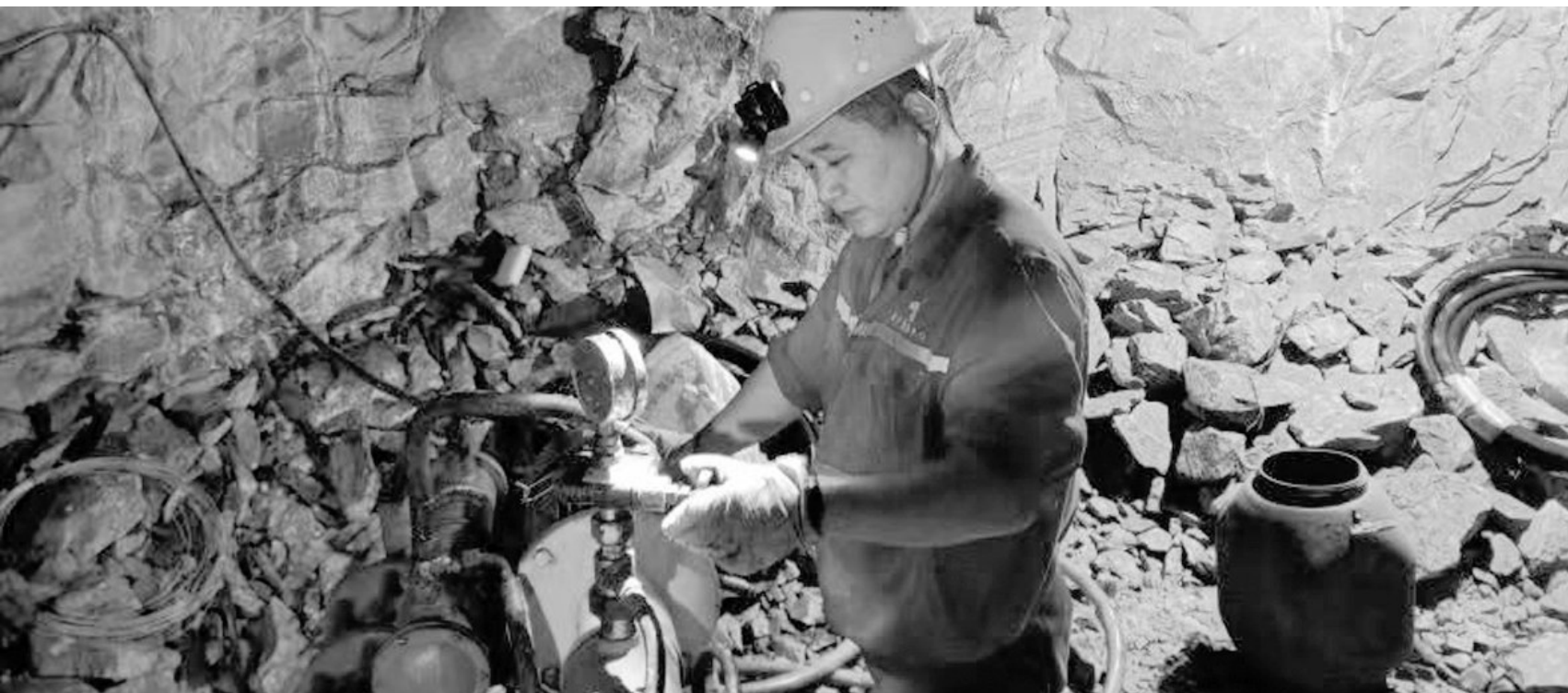
图为马凤超在安庆铜矿负640m中段进行封孔注浆。
