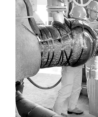
由于近期温度骤降,铜冠(庐江)矿业公司选矿车间提前谋划冬季安全生产工作,积极抓好防寒防冻各项工作。该车间按照“早动手、细管理、抓重点、促效益”的思路,安排专业技术人员和维修人员对重点大型设备进行维护和保养,并为它们换上了“冬装”,避免了“急热遇极寒”导致的管道上冻,全力保障秋冬季关键设备的安全运行。
